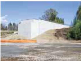
本工事は宇都宮市竹下町で延長59.9m、幅10.4mの区間で行ったLRT事業に伴う工事です。主な工種は中層混合処理工、ジオテキスタイル補強土壁工、重力式擁壁工、橋梁下部工等でした。
