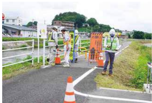
危険個所の立入禁止措置
