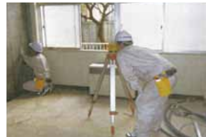
レベルを使用しての墨出しの補助
