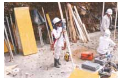
トランシットによる測量実習
