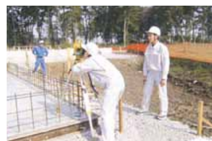
トランシットによる建物通り芯の確認
