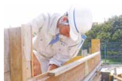
コンクリート型枠組立ての体験
