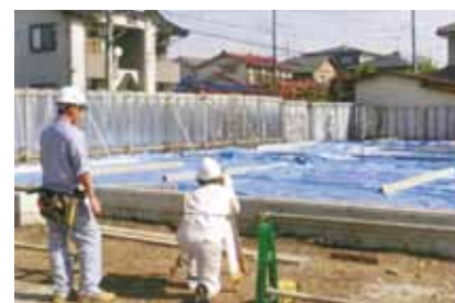
地中梁天端のレベルの確認を実施
