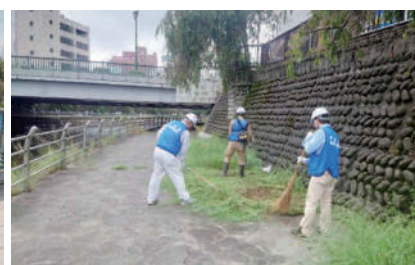
作業状況 宮の橋上流右岸
